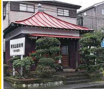
外観周りを修繕
